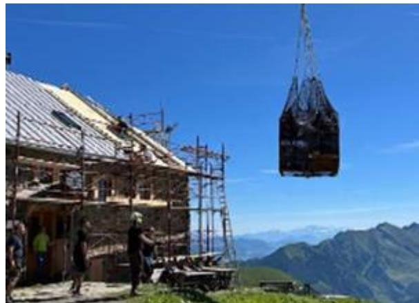
Nach dem Gerüstaufbau wurden die Blechplatten entfernt und ein erster Blick auf den Unterbau wurde frei. Spätestens jetzt war klar - es ist höchste Eisenbahn. Die alten Holzschindel zerbröselten förmlich in der Hand.
